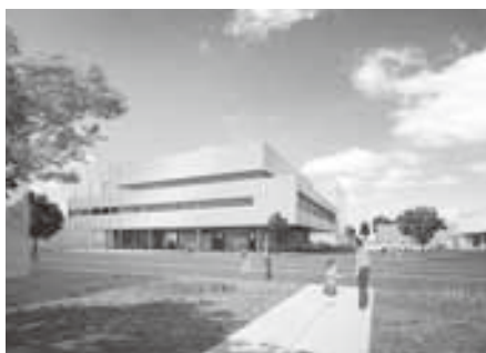
▲東側から見た新庁舎
