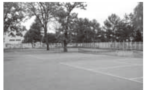
老朽化が進むテニスコート
