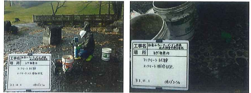
写真 4-1 作業状況(左：採取状況、右：補修状況)
