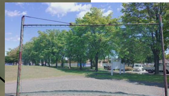
3 芽室南公園運動広場 既存バックネットの撤去
